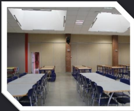
Climatisation au Restaurant Scolaire
