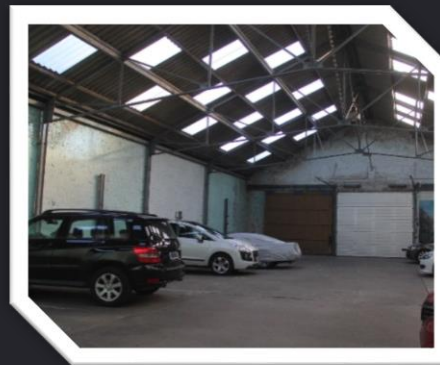
Aménagement des Hangars rue Poutrain
