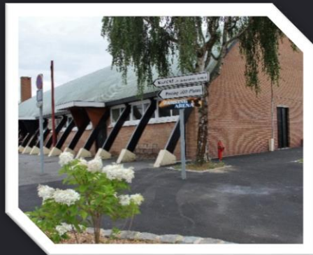
Travaux Salles de Sports transférées de la Communauté de Communes
