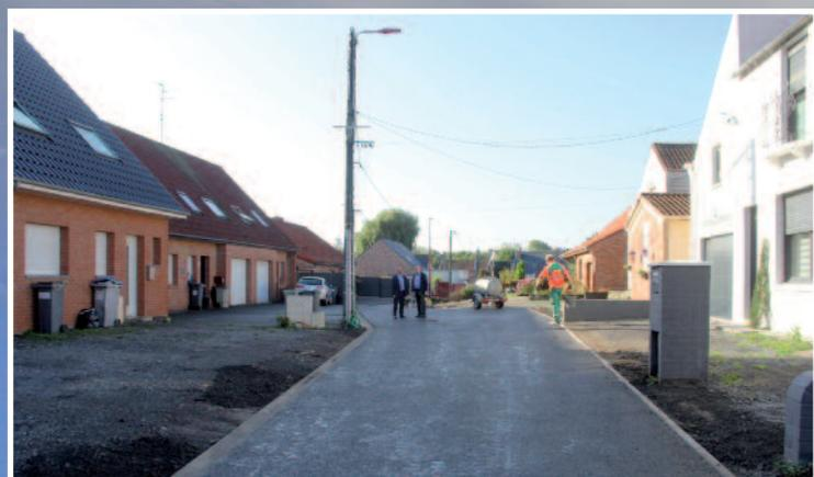
Les riverains du Sentier de la Poste l'attendaient avec impatience : un gros chantier de plusieurs semaines vient de se terminer. Après le raccordement au tout à l'égout et la pose d'éclairage public, la municipalité a finalisé la réalisation d'un enrobé tout le long du sentier. Le montant global des travaux représente un investissement s'élevant à plus de 100 000 euros avec des subventions émanant de la dotation parlementaire et d'un fonds de concours de la CCPC.
